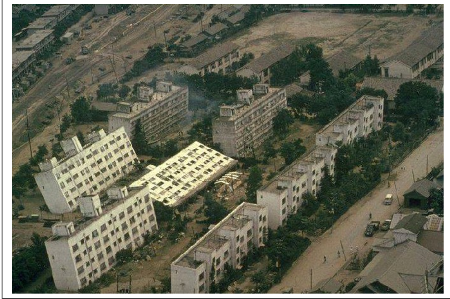
Fig. 2 – Effetti della liquefazione del terreno indotta dal terremoto del 1964 a Niigata (Giappone)
